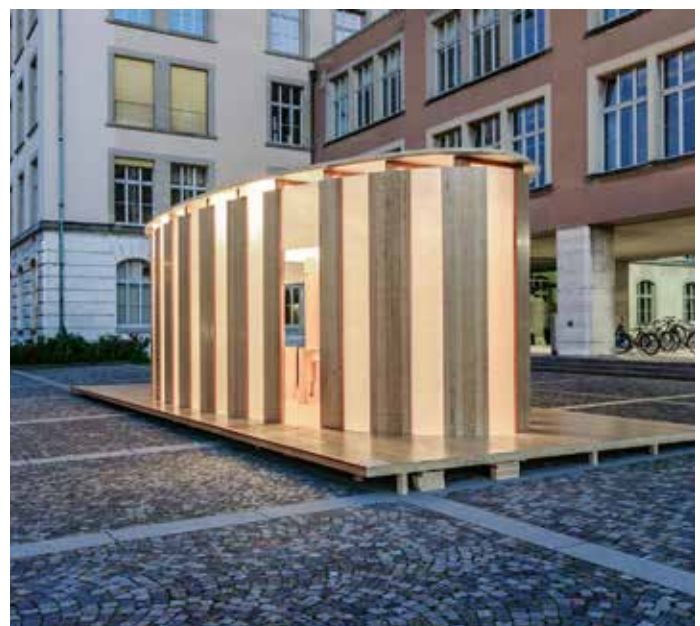
Der Pavillon an der Technikumstrasse wurde von Studierenden im September in einer Woche aufgebaut.
